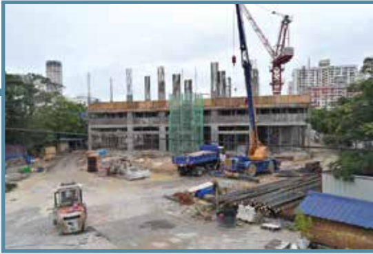
Kerja-kerja Struktur Sedang Dijalankan Untuk Tingkat 2 Cecil Residency, Georgetown
