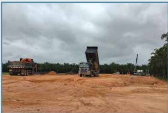
Kerja-Kerja Tanah Sedang Dijalankan - Ladang Byram, Nibong Tebal
