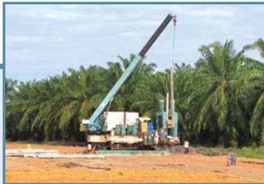
Piling Work - Jalan Sungai Daun, Nibong Tebal
