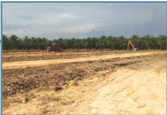
Kerja-Kerja Pematongan Tanah Atas Sedia Ada - Jalan Sungai Daun, Nibong Tebal
