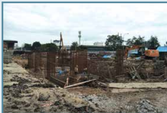
Kerja-Kerja Struktur Sedang Dijalankan Untuk Level 1 - Mak Mandin, Butterworth
