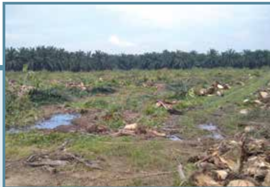
Kerja-Kerja Pembersihan Tapak - Jalan Sungai Daun, Nibong Tebal
