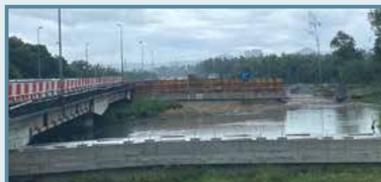
Pelebaran Jambatan Batu Kawan
