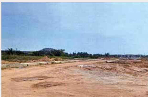
Kerja-kerja memperluaskan Utara Penang Science Park
