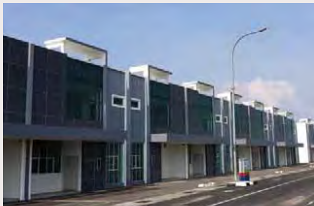
Kilang-kilang jenis teres di Batu Kawan
