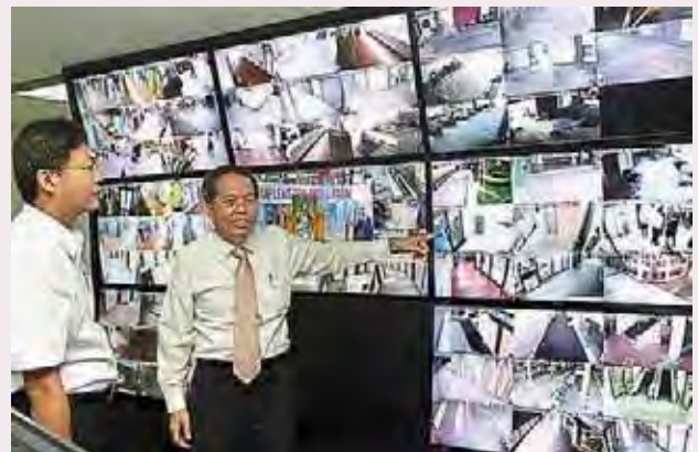
Pemasangan CCTV untuk meningkatkan kawalan keselamatan
