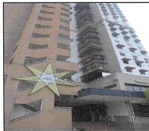
KOMPLEKS JALAN KEDAH GEORGE TOWN
